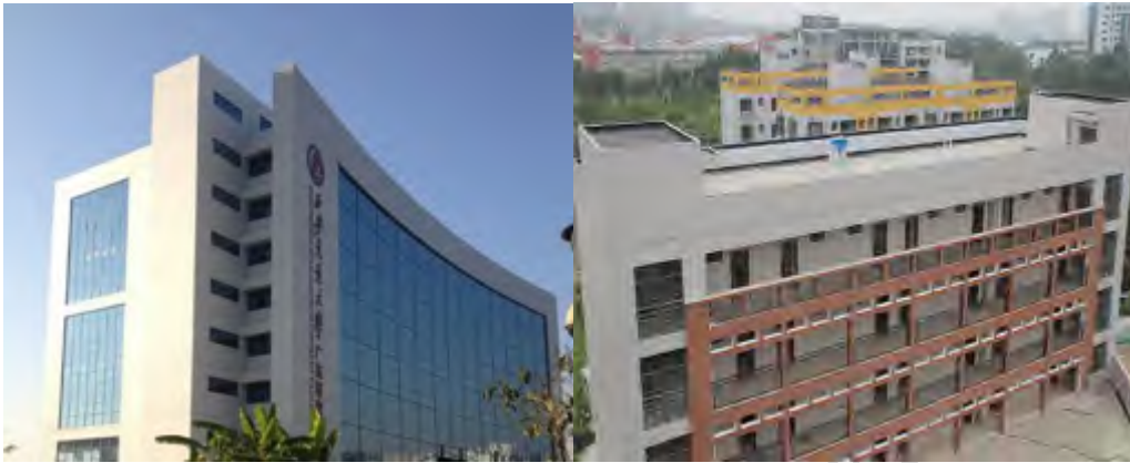
图九 综合楼和员工生活中心
